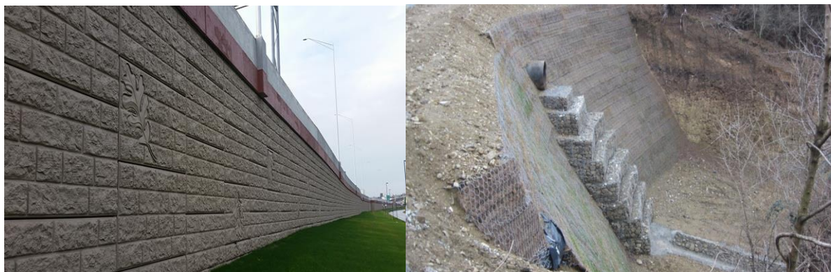
სურათი 4.14.1-1. ტიპური მექანიკურად სტაბილიზირებული გრუნტის კედლები
